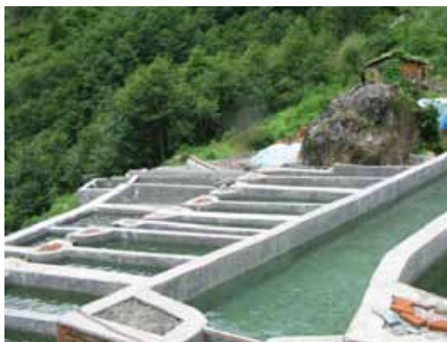
चित्र १. ट्राउट पालनको लागि सिमेन्टको प्रयोगबाट तयार गरिएको पक्की रेसवे पोखरी
